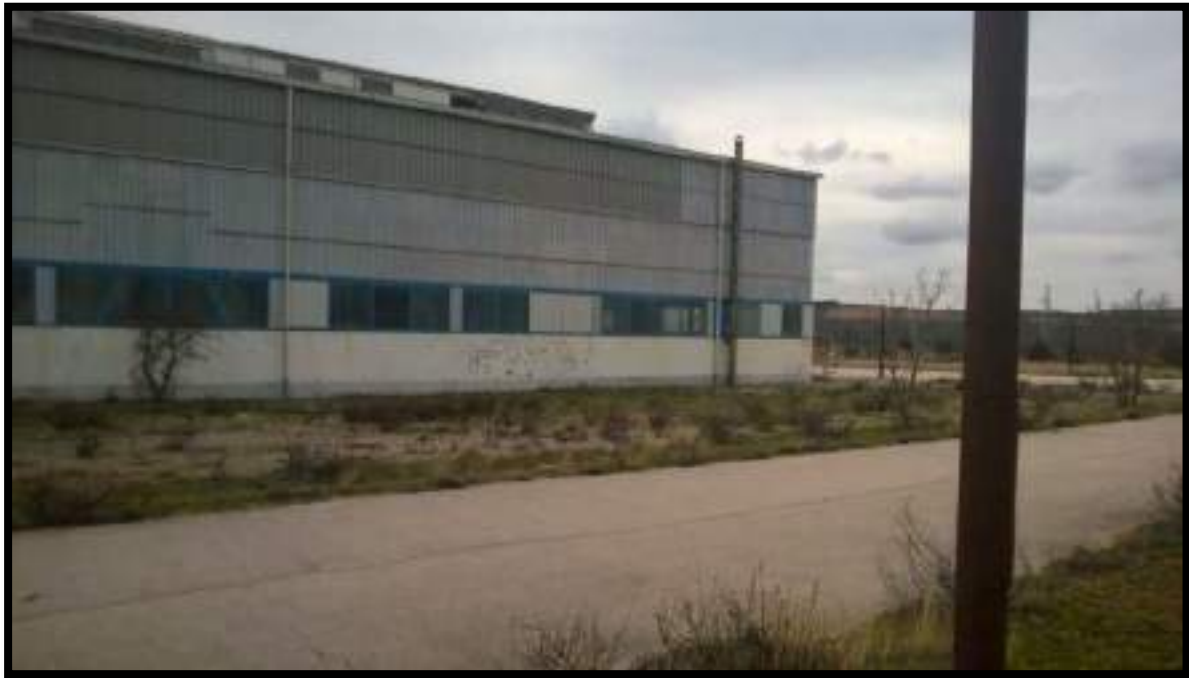
Slika 1 Postojeća hala bivše tvornice (Izvor: fotodokumentacija Maxicon d.o.o.)
